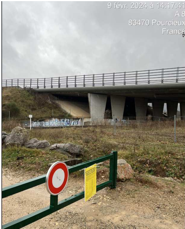
Entrée galerie du Jas sous pont A8 Escota Pourcieux
