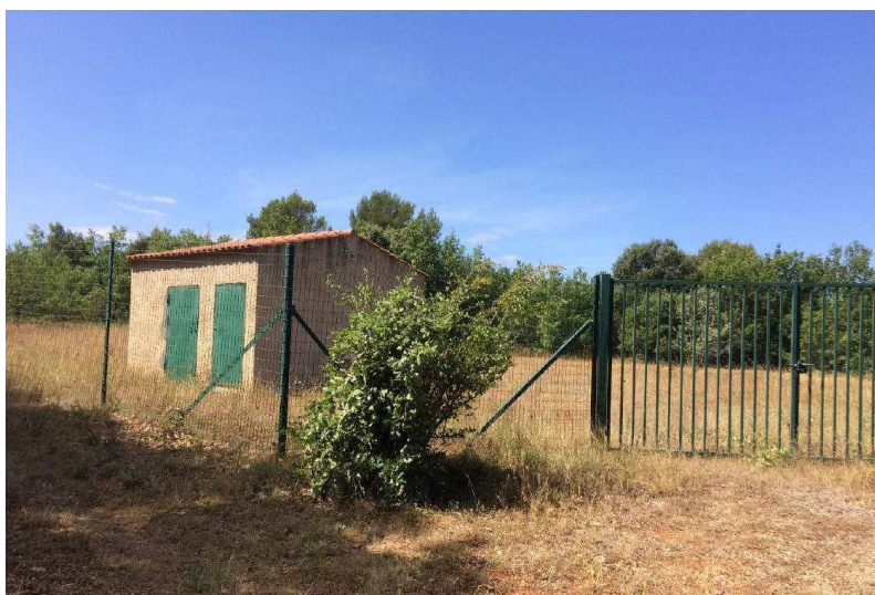
Figure 4 : PPI du forage de Bury à Tavernes dans le Var
