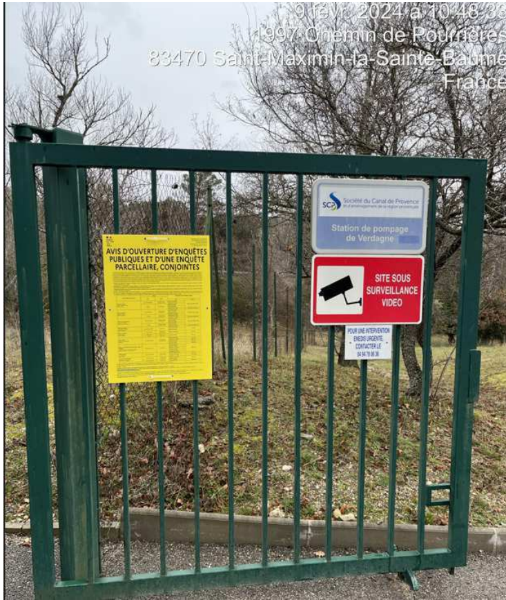
Station de pompage de Verdagne St Maximin
